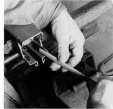
▶ 銅導体の端を平やすりでバリ取りします。
