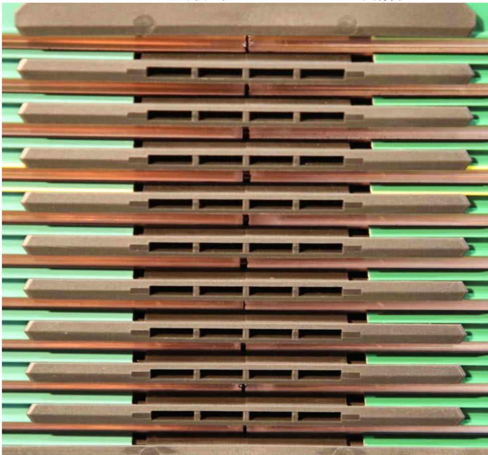
ジョイントキャップ、横配置のコンダクターレール、清掃後
