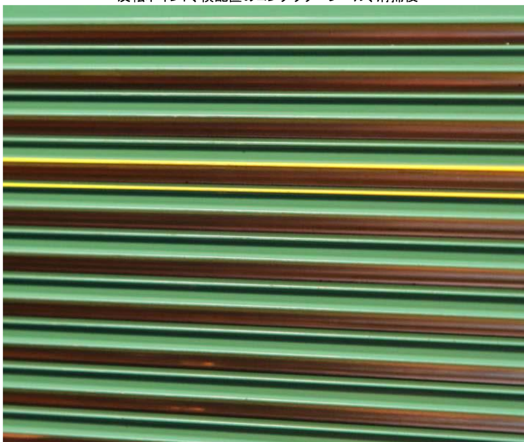
反転ポイント、横配置のコンダクターレール、清掃後
