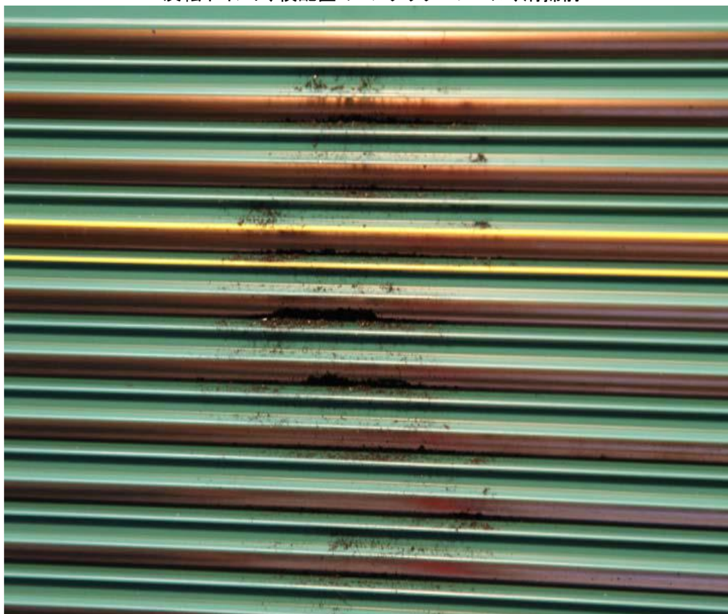
反転ポイント、横配置のコンダクターレール、清掃後
