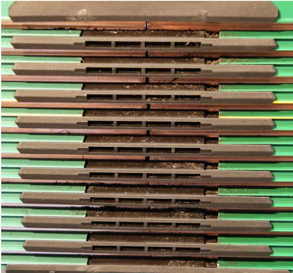
ジョイントキャップ、横配置のコンダクターレール、清掃後
