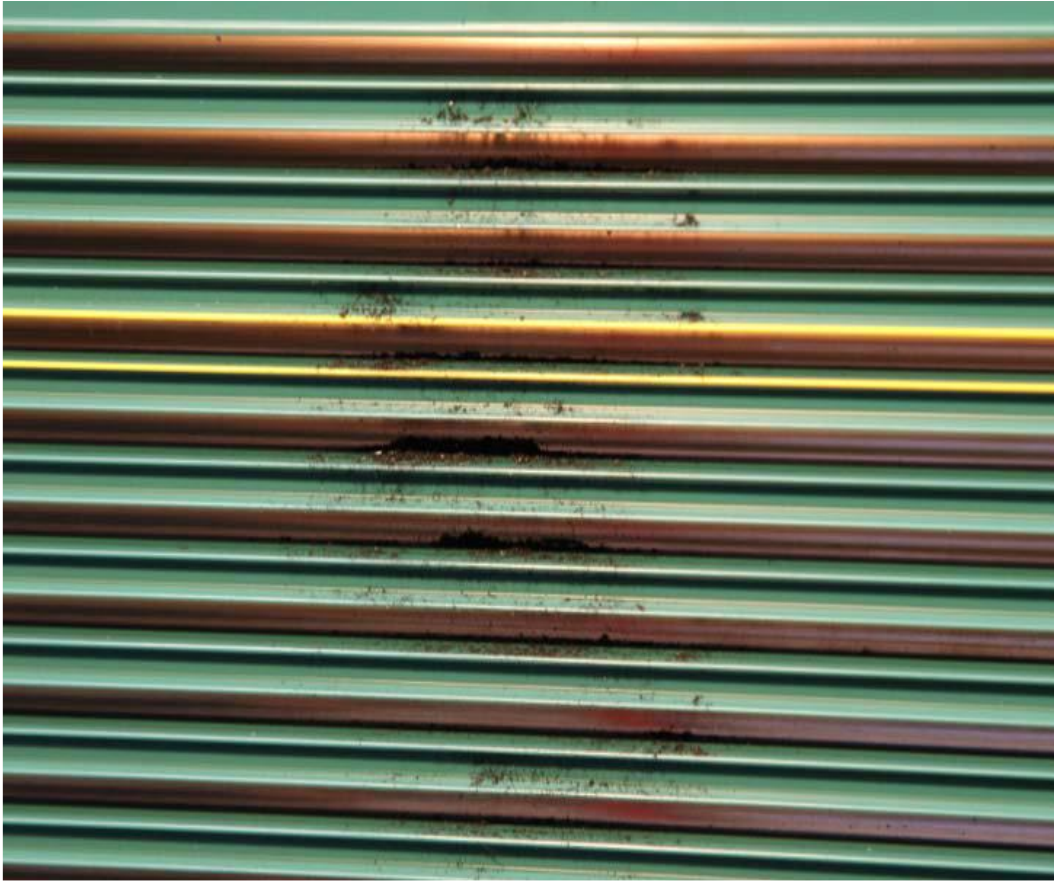
反転ポイント、横配置のコンダクターレール、清掃後
