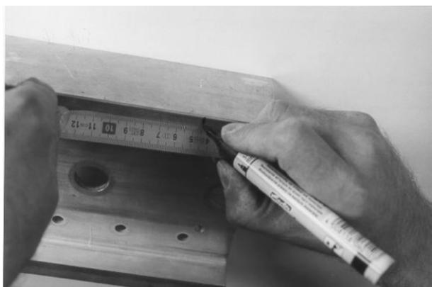
モノレールトラックに穴あけのマーキングをする前にハンガークランプの組立高さを確認してください。16 ページを参照ください。
