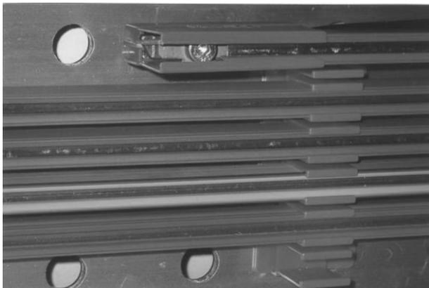
給電端子カバーをコネクタにかぶせてカバーと一緒に押しながらレールカバーの保持溝に沿ってスライドさせます。ストッパーに当たるまで押し込みます。
