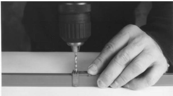
絶縁物と金属レールの背面を貫通して3mmの穴を開けます。接触面まで貫通しないようにしてください。
