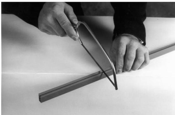
細刃ののこぎりを使用してください(レールの量が多い場合は電動のこぎりを推奨します)。
