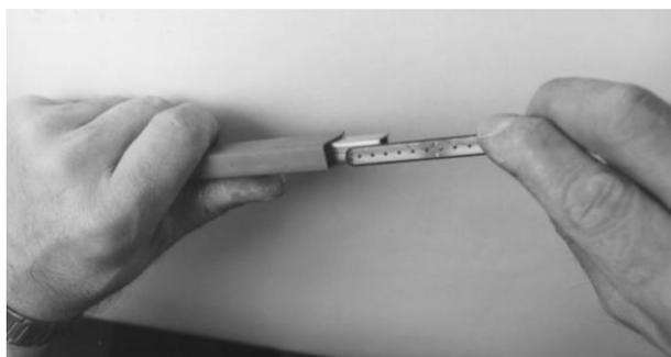
コンダクターレールを適切な長さで切断します。67mm のプラスチックストリップをコンダクターレール末端の銅のすぐ上スリーブの下に挿入します。これによりレールがスリーブの中に押し戻されることを防ぎます。
