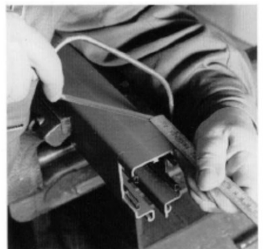
▶ 左右両側の端末から 50mm の上側角に印をつけます。
