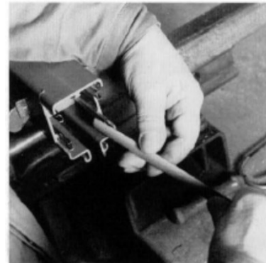
▶ 銅導体の端を平やすりでバリ取りします。
