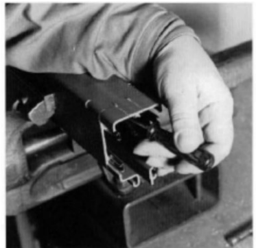
▶ PVC ハウジングから銅導体を 40-50mm の長さまで持ち上げます。
